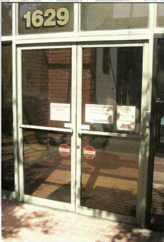
Fot13.87 O ușă cu cadru din metal tipică cu panouri de sticlă temperată într-o clădire comercială.
