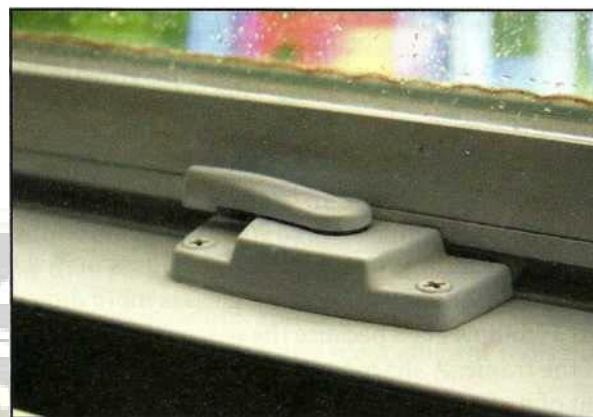
Fot13.105 Un aparat de blocare tipic într-o fereastră cu guilotină
