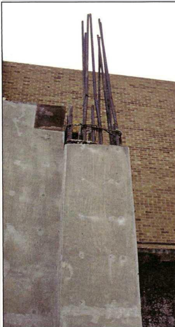
Fot13.122 Majoritatea zidurilor de construcții sunt întărite cu bare de oțel
