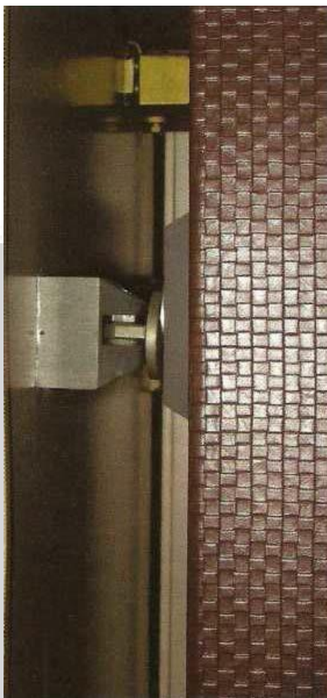
Fot13.64 Dispozitiv magnetic pentru a menține o ușă deschisă.
