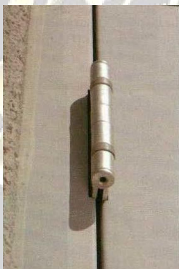
Fot13.82 Câteva uşile au balamale expuse cu un gol în partea de jos care permite ca pasatorul marea expulsată. Apoi, ea uşa poate ser îndepărtată de cadru.
