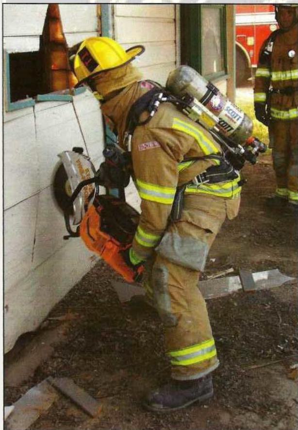
Fot13.30 Când operează orice tip de fierăstrău electric, mențineți zona de lucru despejată de către spectatori
