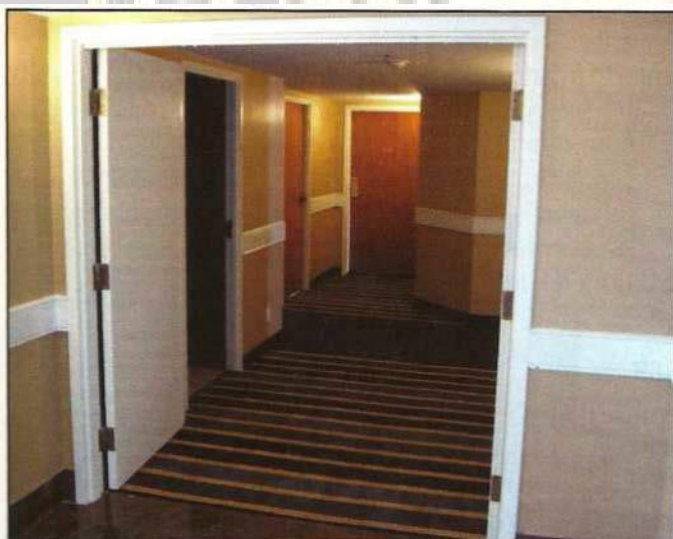
Fot13.66 Ușile cortafoc în coridoare ocupate, de obicei, sunt deschise
