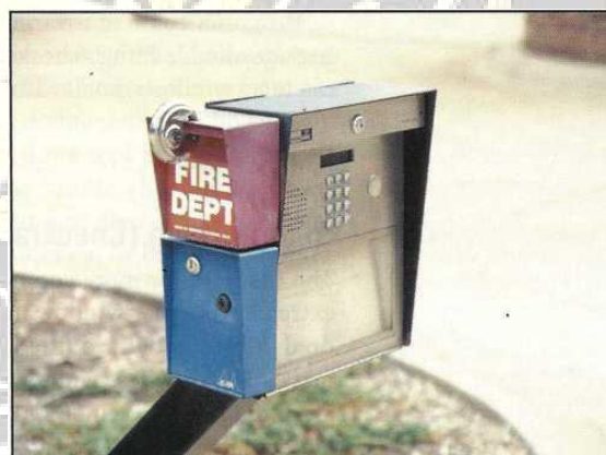
Fot13.103O cutie de siguranță sau tastatura accelerează introducerea prin o ușă închisă.
