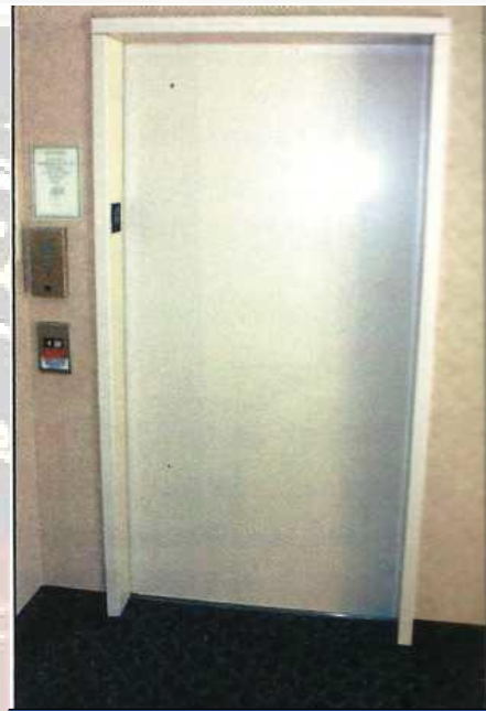
Fot13.61 Una ușă corrediza orizontală folosită pentru a proteja golul unui lift
