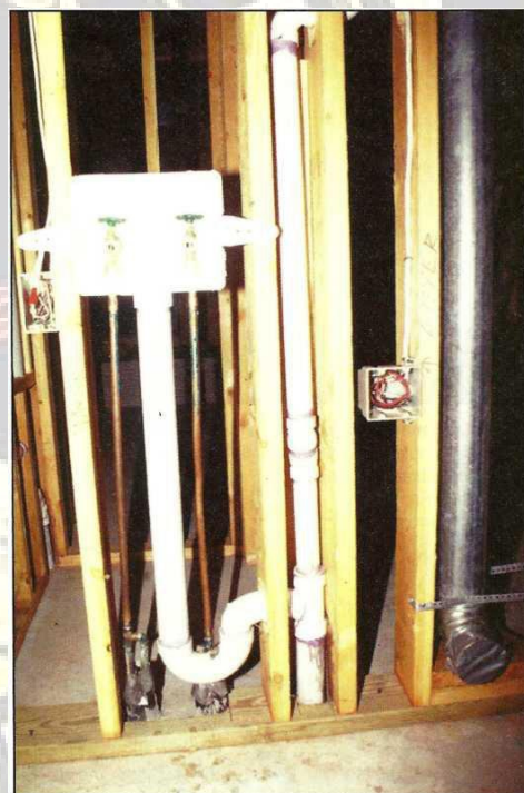
Fot13.116 Fii atent cu țevi și cablu când voi sparge zidurile.
