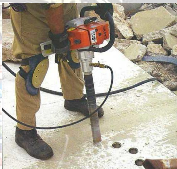
Un ciocan pneumatic poate fi folosit pentru a sparge pardoseli de beton și tăierea molozului în colapsuri de clădiri.
