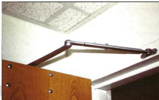
Fot13.63 Mecanism de auto-închidere al unei ușa
