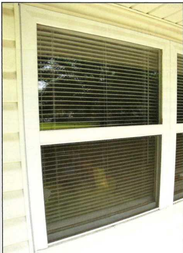
Fot13.104 Feroneria de fereastră cu guilotină pot fi construite din lemn, metal, vinil.
