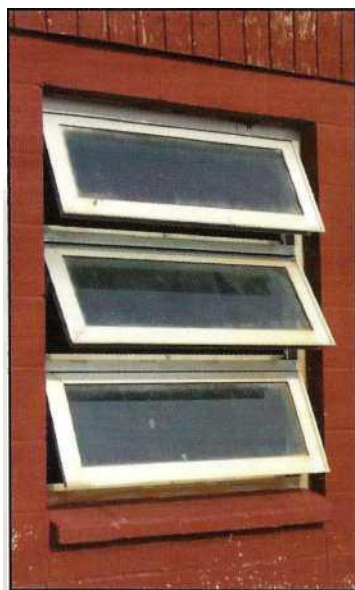
Fot13.109 Un tip de fereastră cu grilaj lat cu balama în parte superioară a fiecărei panou
