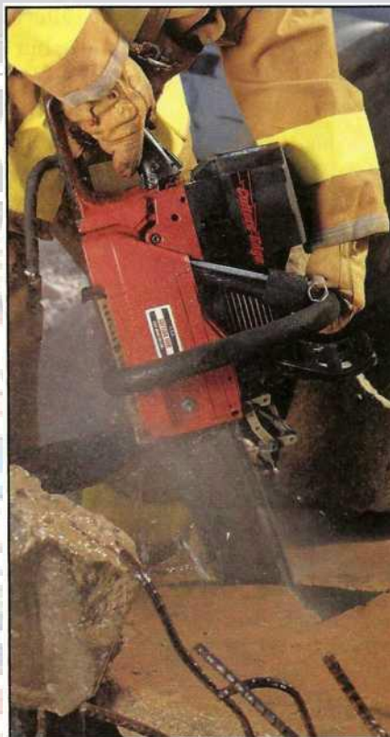
Fot13.123 O feronerie de cadenas cu o fâșie de mamposteria este foarte eficientă pentru a sparge un zid de concret sau tăierea materialelor colapsați durante una operație de salvare.
