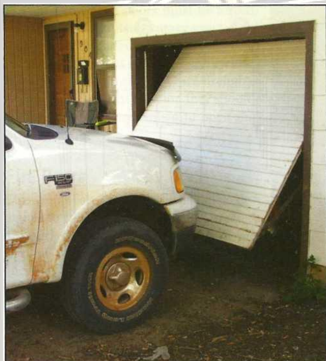
Fot13.51 O ușă basculantă solidă poate a fi obstrucționată parcând vehicule materiale în interiorul zonei de garaj.
