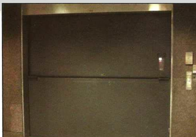
Fot13.62 O ușă contrafoc con contrapeso care constă de două secțiuni care se retrag deasupra și pe sub deschiderea
