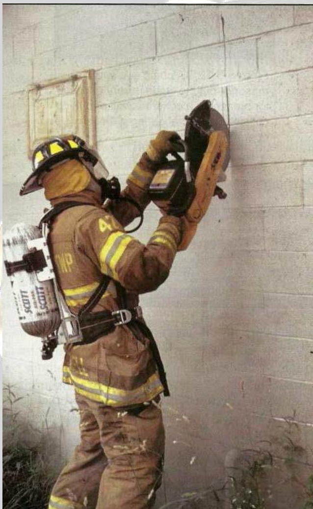
O feronerie electrică poate fi folosit pentru a sparge ziduri de zidărie.
