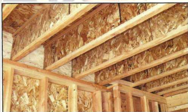
Fot13.127 utilizarea ingineriei de grinzi de lemnul în construcția clădirilor este crescând în popularitate.
