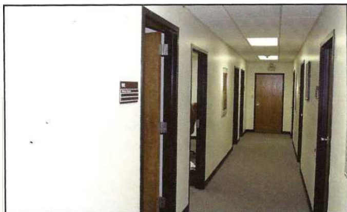
Fot13.117 Majoritatea zidurilor interioare sunt acoperite de gips
