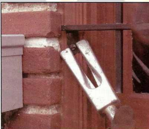
Fot13.113Bare în bare de securitate pot fi îndepărtate cu un spurt sau un rambar.
