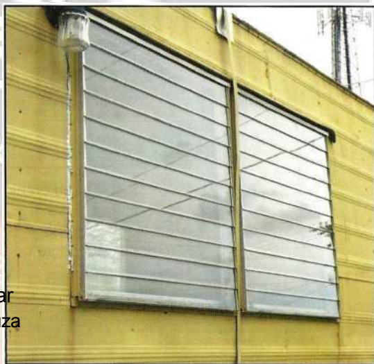
Un tip de fereastră cu obloane angosta care constă din multiple pane de 4 inci (100mm)
